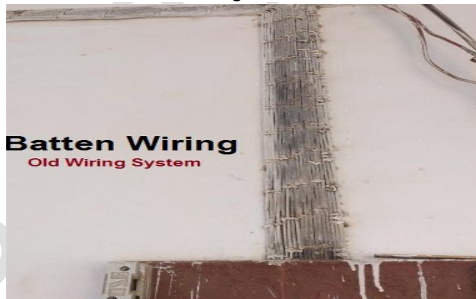
(Fig.5.3. Batten Wiring)
